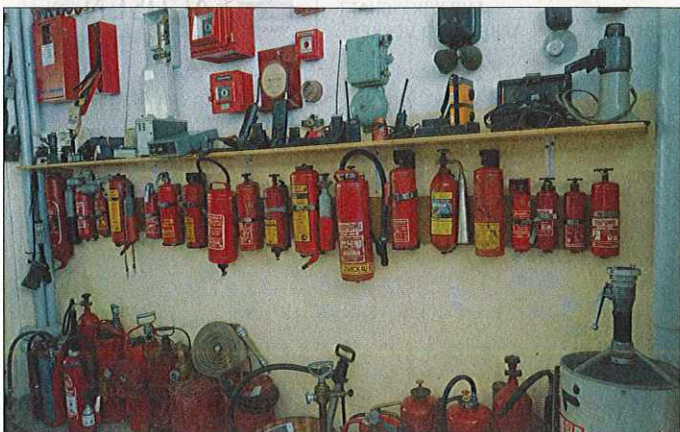
Feuerlöscher und Feuermelder aus vergangener Zeit.
