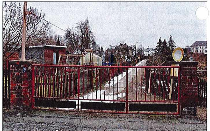
Eingang und Hauptweg der Gartensparte „Scherberg“, Thomas-Mann-Straße werden mit Hilfe von Fördermitteln aus dem Verfügungsfonds erneuert und ansehnlicher gestaltet. Foto: P. Dittmann
